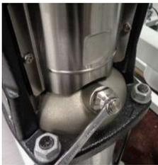
3. Abra con cuidado el tornillo de ventilación de la bomba hasta que pueda ver una salida de agua. Luego, vuelva a cerrar el tornillo y reinicie el solenoide.
