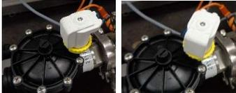
2. Eingangsventil manuell öffnen. Hierzu weiße Magnetspule um 45° gegen den Uhrzeigersinn drehen.
