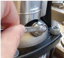
3. Schraube zur Pumpenentlüftung vorsichtig öffnen, bis ein Wasseraustritt festzustellen ist. Anschließend Schraube wieder schließen und Magnetspule wieder zurückstellen.
