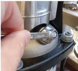
3. Ouvrez soigneusement la vis de ventilation de la pompe jusqu'à ce qu'une sortie d'eau soit visible. Puis refermez la vis et réinitialisez le solénoïde.
