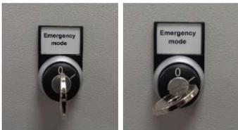
2. Mettez l'interrupteur à clé en position 1. La pompe démarre
