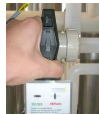
Dreiwegehahn Position Abfluss
