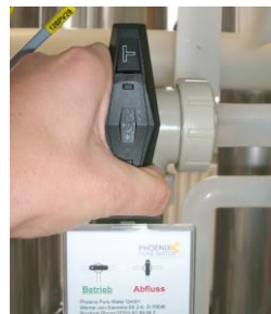
Válvula distribuidora de tres vias posicao desague
